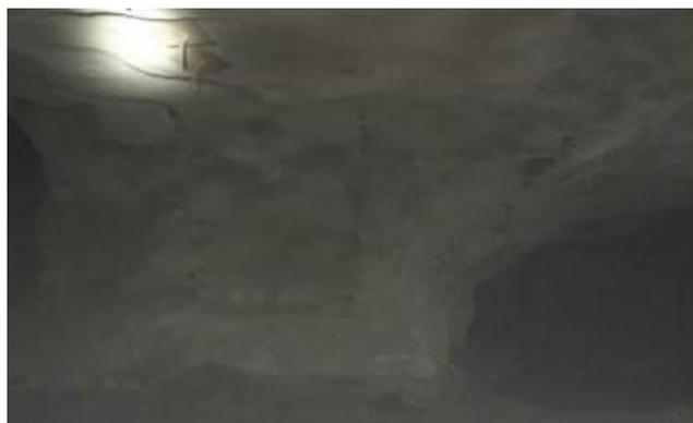
**Foto 07: Sostenimiento con shotcrete del pilar, NV 18, TJ 265 SE.**
