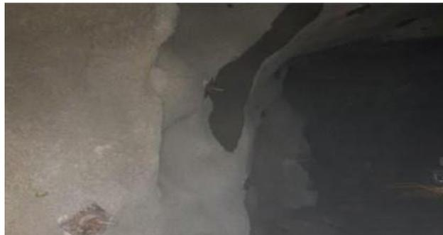
**Foto 06: Sostenimiento con shotcrete del pilar, NV 18, TJ 265 SE.**
