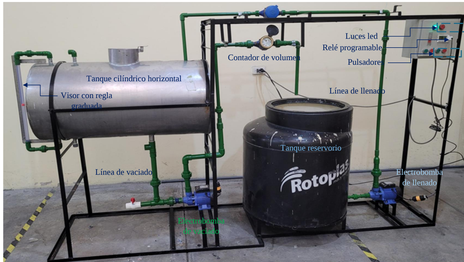
Figura 18. Equipo para el control dinámico de líquidos en tanques cilíndricos horizontales, después de la implementación del sistema automatizado.
