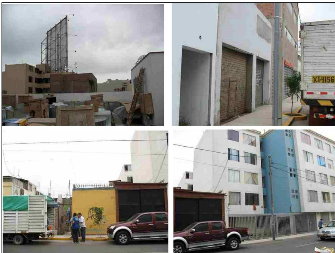
Figura 3. Predios y viviendas cercanas a la instalación
